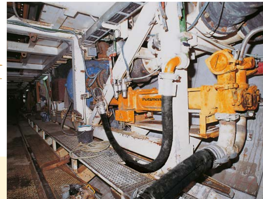
Eine KOV 1050 pumpt Injektionsmörtel hinter die Tübbinge
