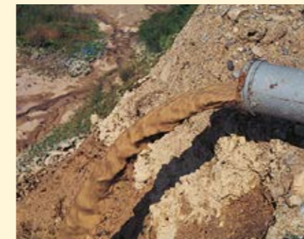
Tunnelentschlammung
