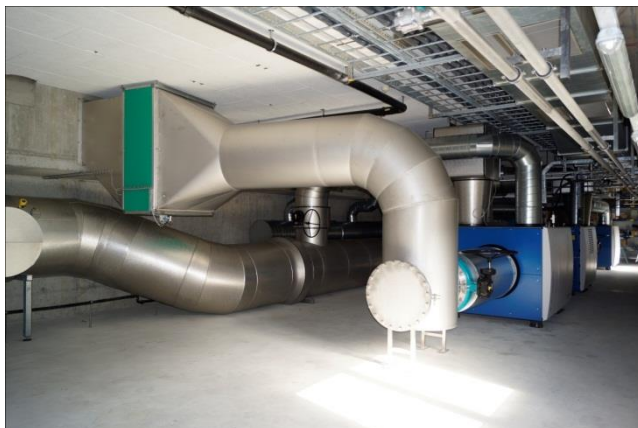
Bild: Die Anlage nach dem Umbau
