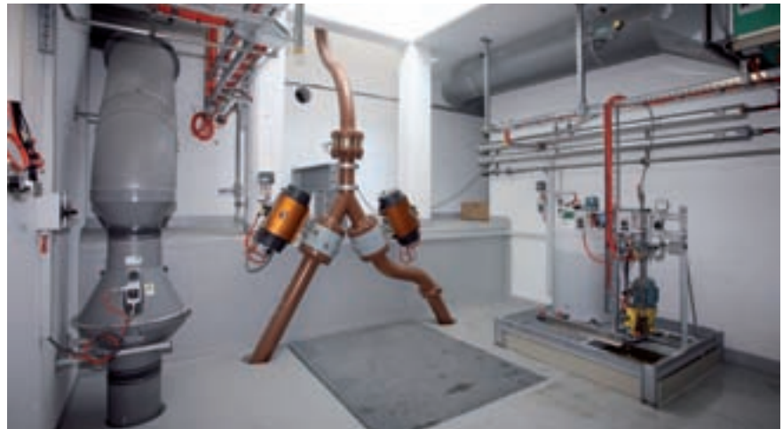
BLI – Einheit für die Schmierung der Rohrleitung beim Anstieg des Druckverlusts
