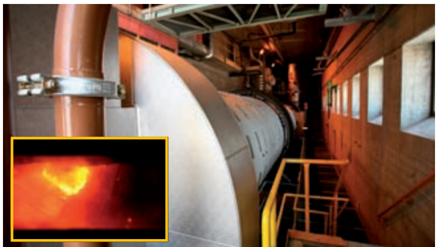
Drehrohrofen für die Verbrennung von Klärschlamm
